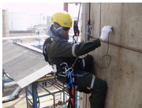
b) Kỹ thuật viên kiểm tra chất lượng bồn với thiết bị thủ công
